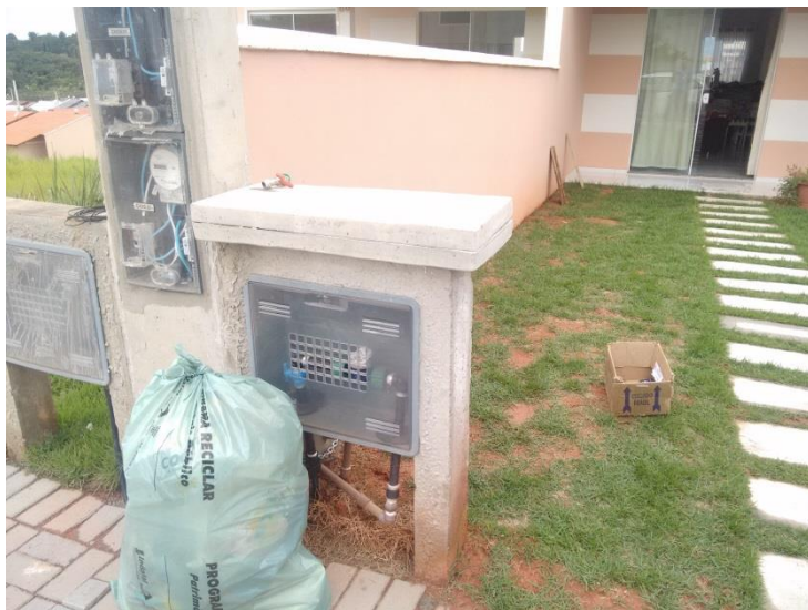
Figura 1 – Rua São Nicolau, nº 87 - Loteamento Nova Indaial, Bairro João Paulo II, Indaial/SC
