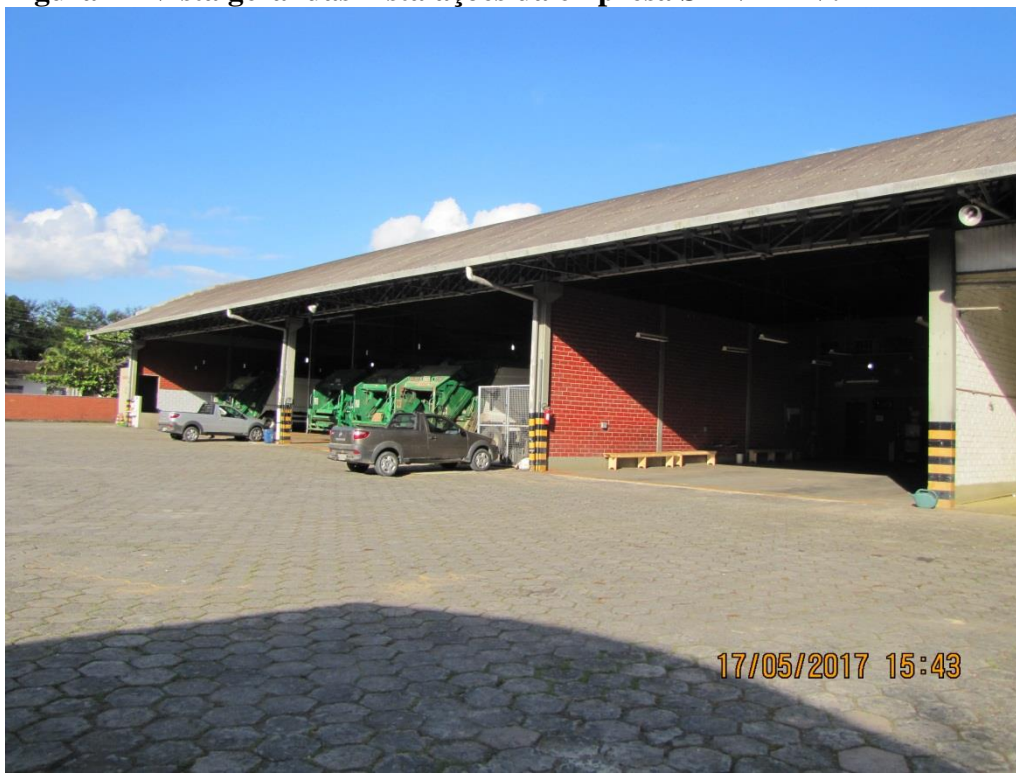
Figura 2 - Vista geral das instalações da empresa SANEPAV.
