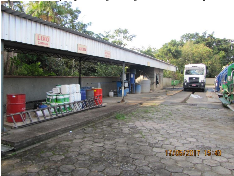
Figura 8 – Instalações para lavagem integral dos veículos e depósito de materiais.
