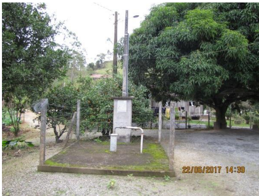
Figura 3: Poço de captação de água bruta do Bairro Beira-Rio.
