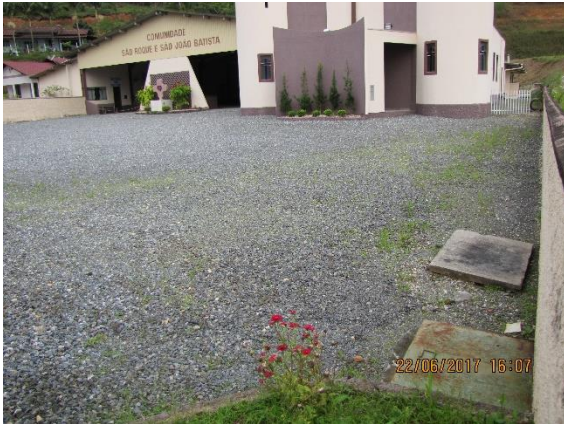
Figura 7: Local do poço de captação de água bruta do Bairro Pedras Grandes.
