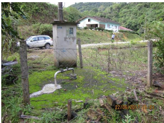
Figura 5: Poço de captação de água bruta do Bairro Lajeado.
