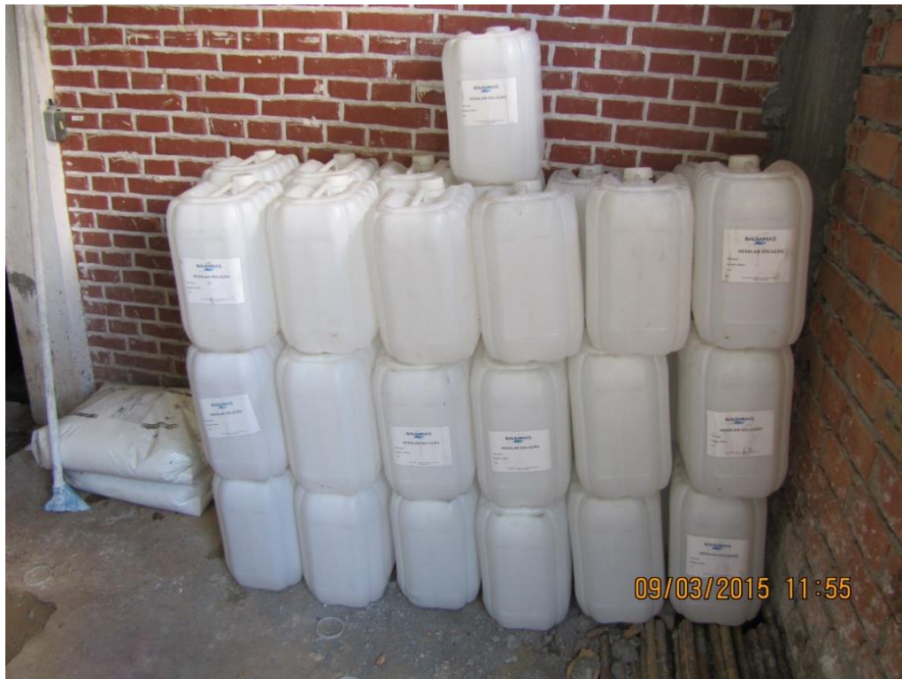
Figura 08 – ETA Central: Ausência de estrado de madeira e bacia de contenção para isolamento entre produtos químicos e o piso - não conformidade
