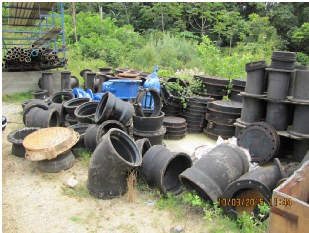
Figura 11 – ETA Central: Materiais novos para adutoras de água dispostos no pátio externo diretamente no solo - não conformidade
