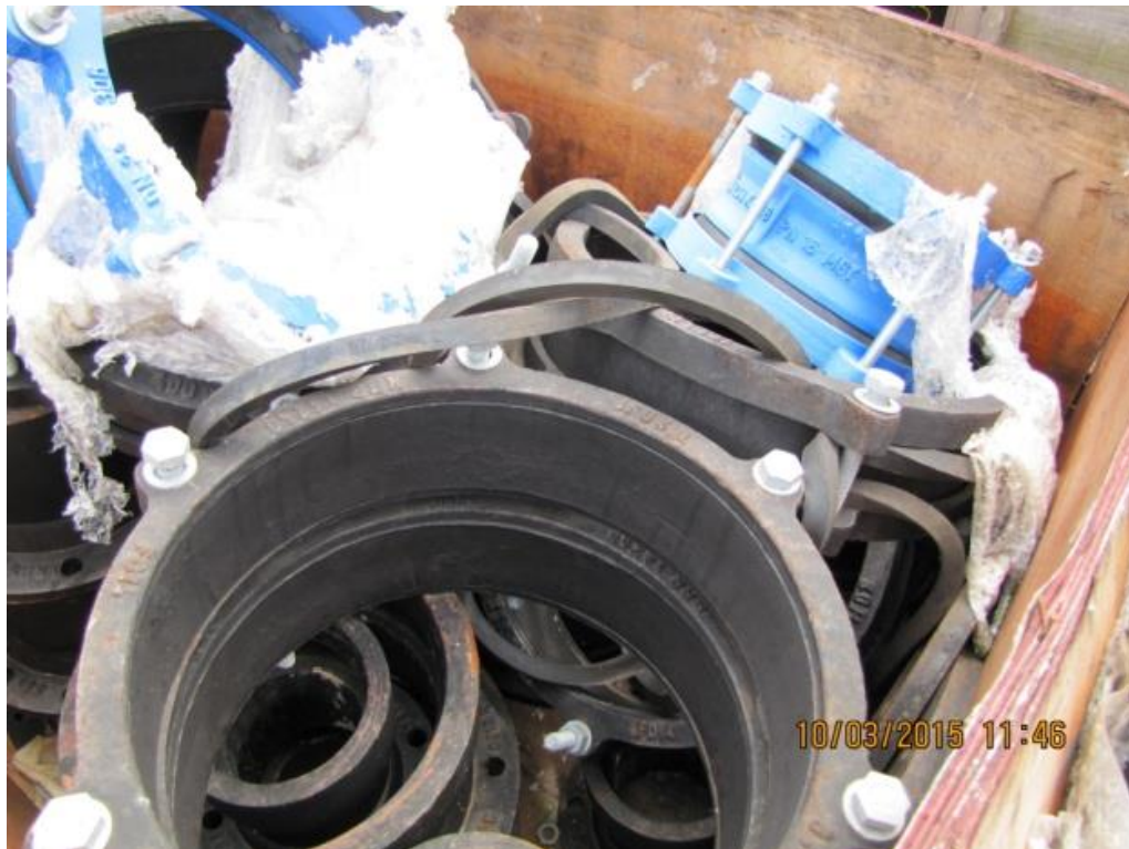
Figura 12 – ETA Central: Detalhe dos materiais novos para adutoras de água dispostos inadequadamente no pátio externo - não conformidade
