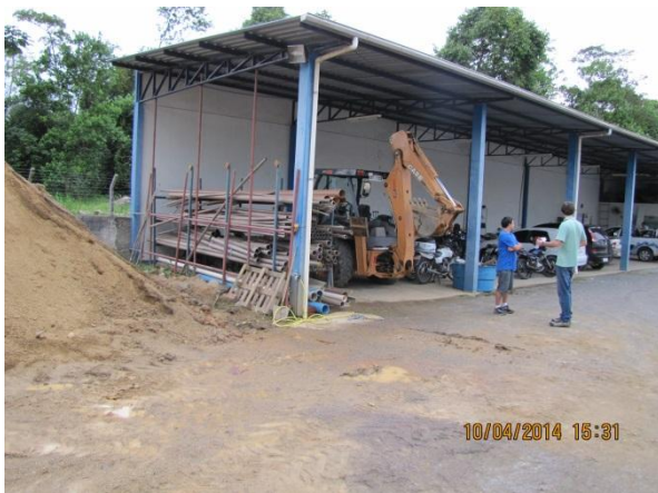
Figura 218 – Escritório Operacional: Vista geral da garagem e frota de veículos - conformidade
