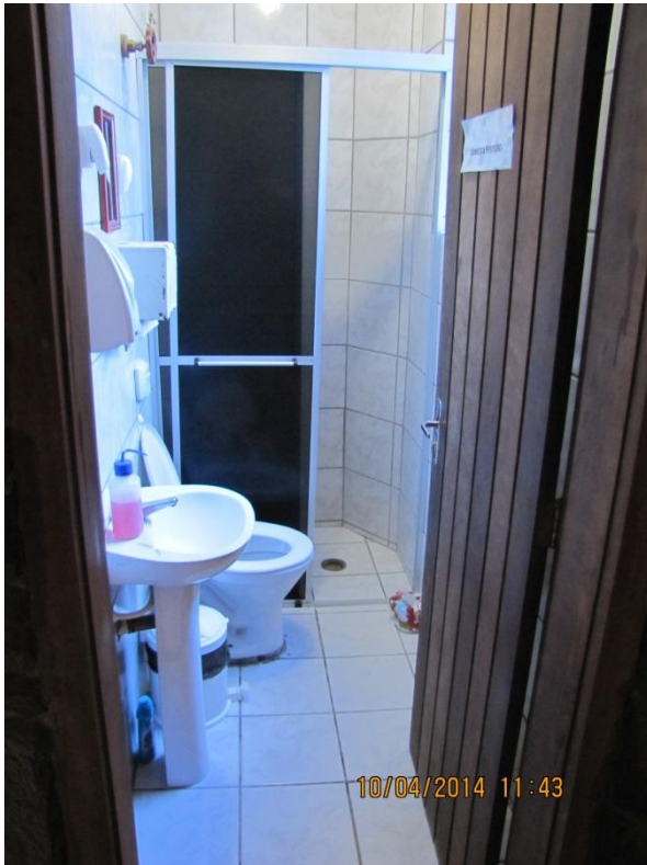
Figura 109 – ETA: Banheiros em condições satisfatórias de organização e limpeza - conformidade
