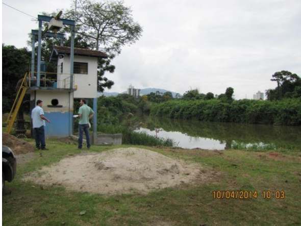
Figura 7 – Captação: Vista geral Ponto de captação apresenta-se próximo a curvatura externa do curso de água – conformidade
