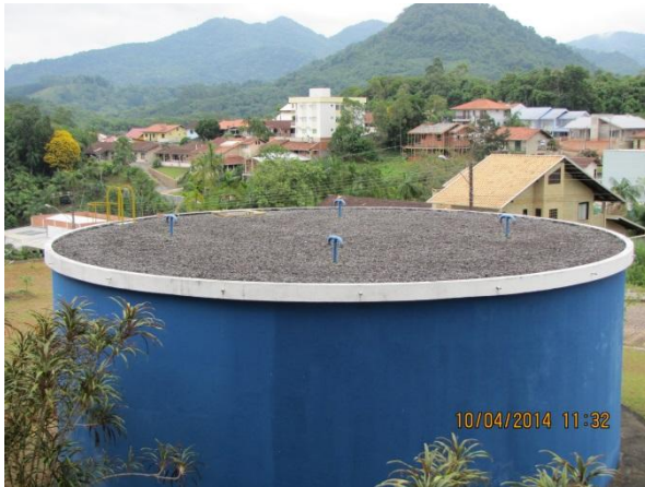
Figura 165 – Reservatório ETA: Presença de tubos de ventilação e drenos de limpeza da laje de cobertura - conformidade
