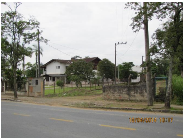
Figura 5 – Captação: Ausência de portão de acesso, identificação e cerca de isolamento adequada ao redor das instalações – não conformidade
