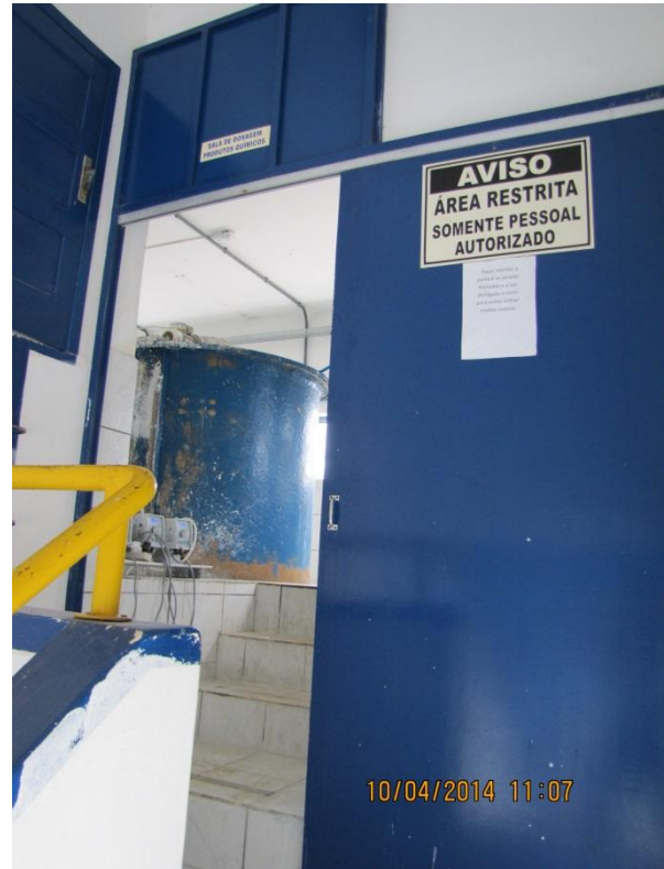
Figura 60 – ETA: Casa de Química com sinalização contra o acesso de estranhos - conformidade
