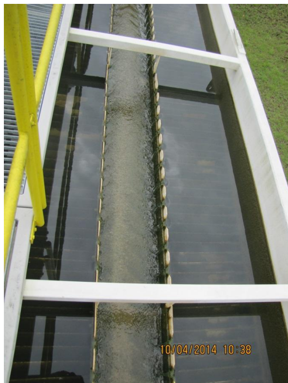
Figura 50 – ETA: Detalhe do decantador e calha vertedora - conformidade
