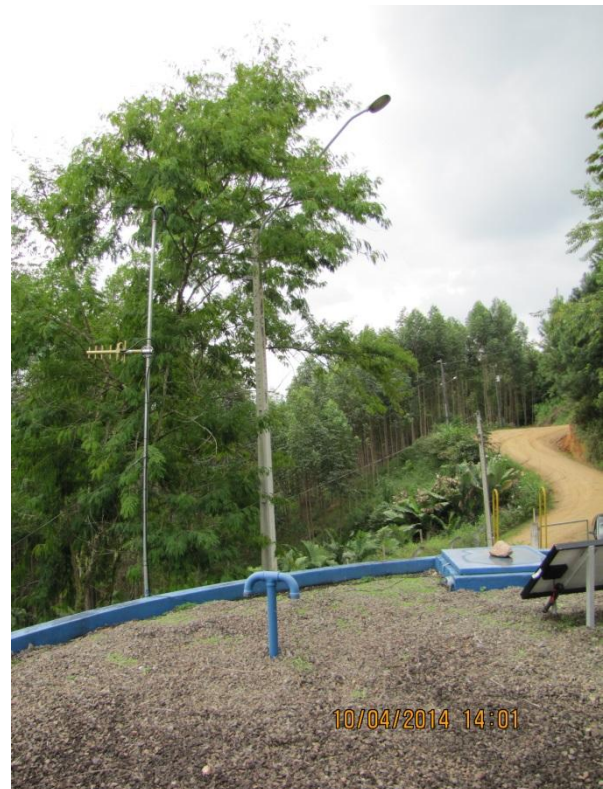
Figura 174 – Reservatório: Sistema de telemetria e iluminação para trabalhos noturnos - conformidade
