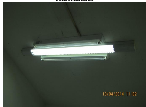
Figura 104 – ETA: Detalhe da presença de lâmpada ultravioleta do laboratório de análises bacteriológicas - conformidade
