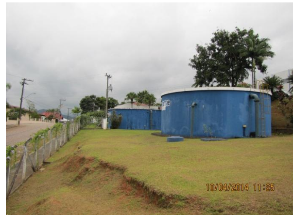
Figura 154 – Reservatório ETA: Vista geral Condições satisfatórias de manutenção e limpeza do entorno do reservatório – conformidade Presença de pintura de identificação da autarquia, portões e cerca de isolamento contra o acesso de estranhos – conformidade Ausência de iluminação adequada para trabalhos de manutenção noturnos – não conformidade
