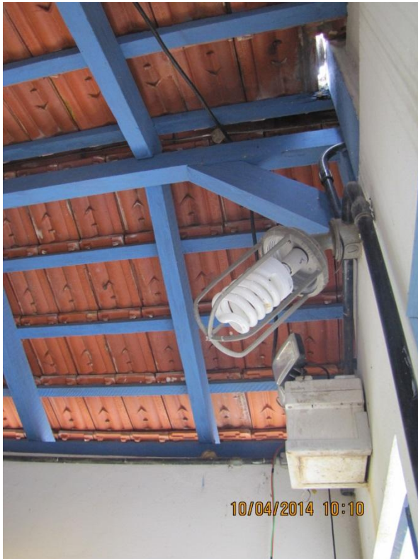
Figura 15 – Captação: Iluminação para trabalhos noturnos - conformidade
