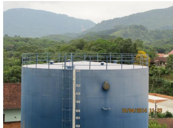
Figura 166 – Reservatório ETA: Presença de tubos de ventilação - conformidade
