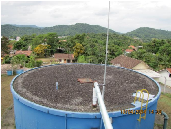
Figura 185 – Reservatório: vista superior
