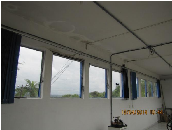
Figura 43 – ETA: Vista geral das instalações dos registros de manobra
