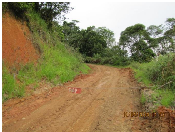
Figura 187 – Reservatório Rua Tamoio: Estrada de acesso em boas condições - conformidade Presença de corrente e cadeado para o controle de veículos - conformidade
