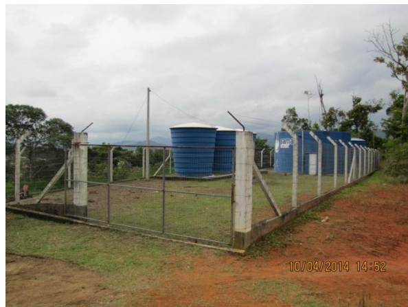
Figura 188 – Reservatório: Presença de cerca de isolamento e portão de acesso com travamento adequado - conformidade
