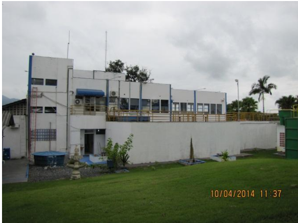
Figura 25 – Vista geral da ETA convencional Presença de fissura e pequeno vazamento na parede do floculador – não conformidade
