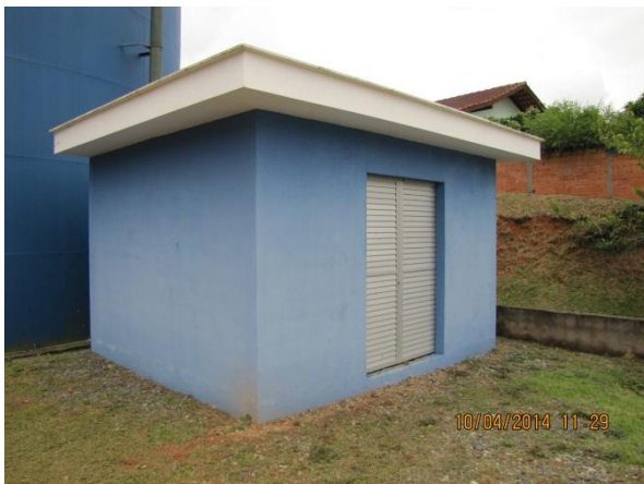
Figura 148 – Estação Elevatória ETA: Vista geral
