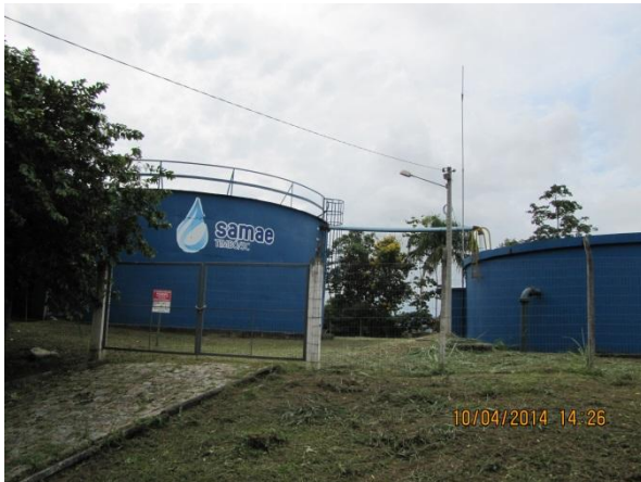
Figura 175 – Reservatório Rua Rodeio: Pintura de identificação da autarquia – conformidade Presença de cerca de isolamento e portão de acesso com travamento adequado - conformidade
