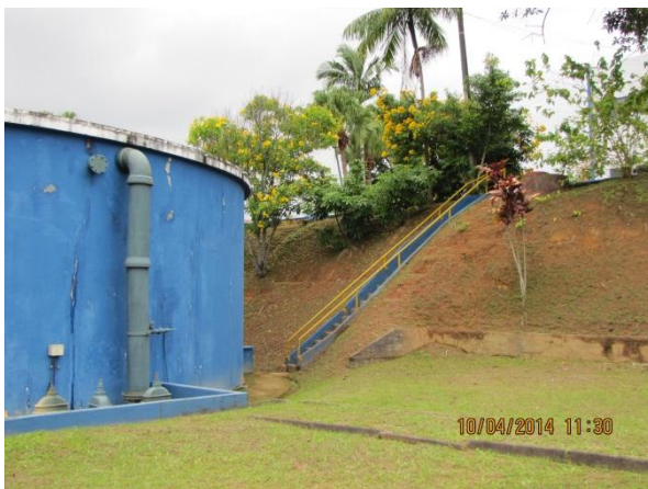
Figura 161 – Reservatório ETA: Escada de acesso - conformidade
