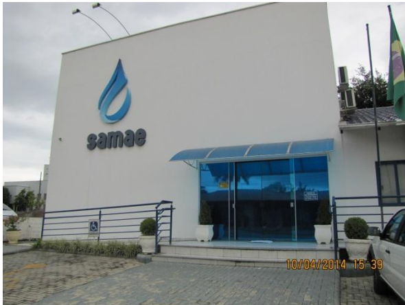
Figura 225 – Vista geral do escritório operacional e atendimento ao cliente com rampa de acesso para deficientes físicos - conformidade
