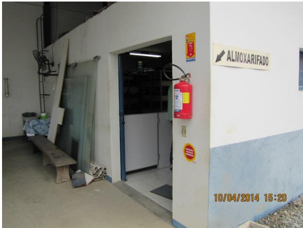
Figura 198 – Escritório Operacional: Vista geral das instalações do almoxarifado Extintores de incêndio – conformidade Controle de acesso contra pessoas estranhas - conformidade
