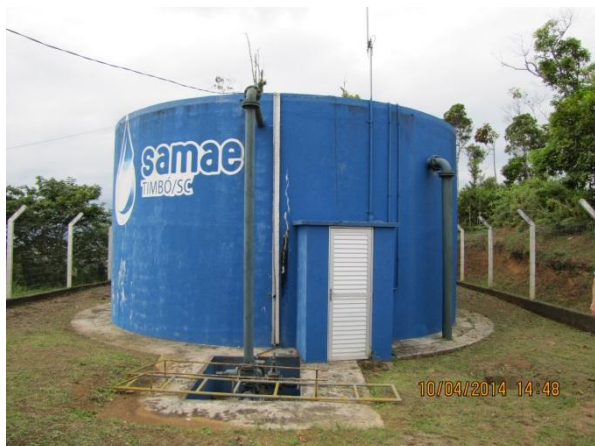
Figura 189 – Reservatório: Sistema de telemetria e pintura de identificação da autarquia – conformidade
