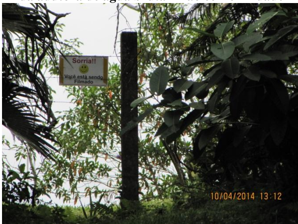
Figura 23 – ETA: Cerca de isolamento e placa de sinalização contra o acesso de estranhos - conformidade
