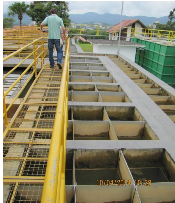
Figura 30 – ETA: Passarela externa para operação/manutenção dos floculadores com ausência de guarda-corpo de segurança para os operadores - conformidade
