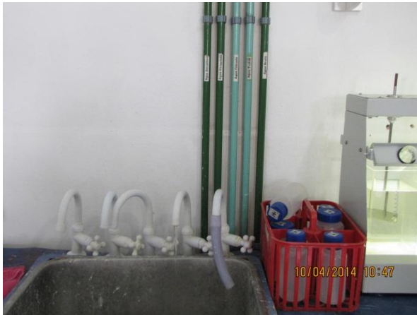
Figura 77 – ETA: Detalhe da presença de identificação dos pontos de coletas e amostras para análises – conformidade
