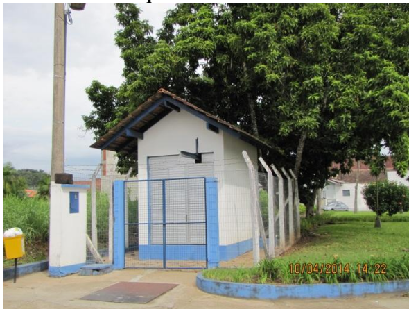
Figura 124 – Estação Elevatória: Vista geral da Estação Elevatória localizada na Rua Quintino Bocaiúva, Bairro Quintino
