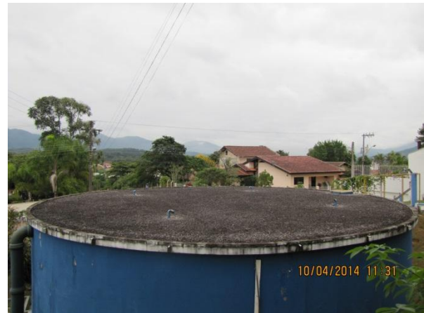
Figura 162 – Reservatório ETA: Presença de tubos de ventilação e drenos de limpeza da laje de cobertura - conformidade
