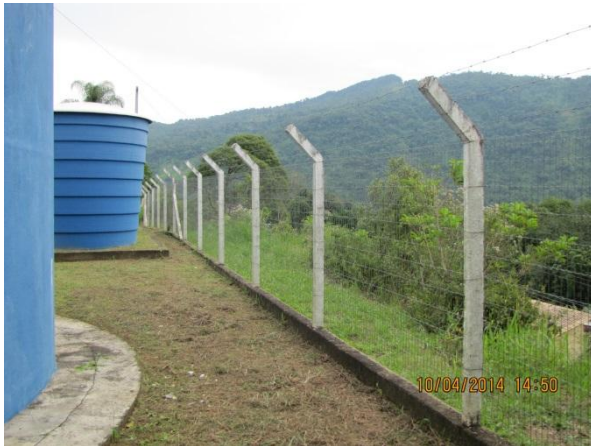
Figura 193 – Reservatório: Condições satisfatórias de manutenção e limpeza do entorno do reservatório – conformidade
