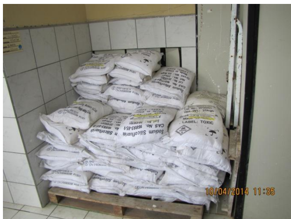
Figura 69 – ETA: Estocagem de produtos químicos sobre estrado de madeira - conformidade
