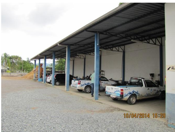
Figura 214 – Escritório Operacional: Vista geral da garagem e frota de veículos - conformidade
