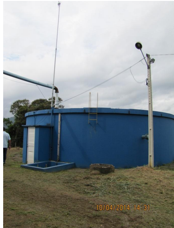
Figura 184 – Reservatório: Sistema de telemetria e iluminação para trabalhos noturnos - conformidade
