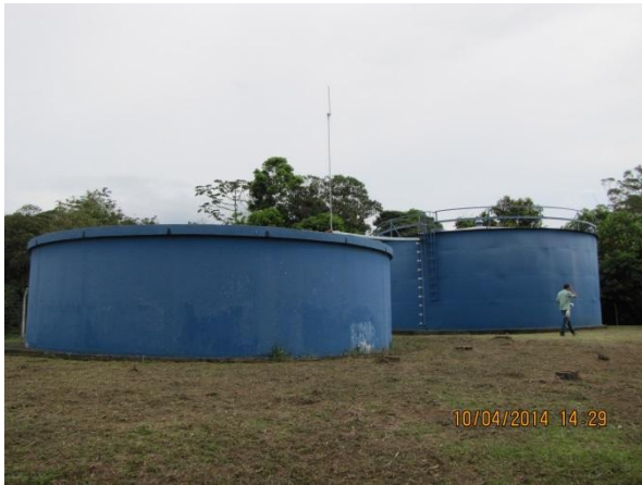
Figura 179 – Reservatório: Vista geral Condições satisfatórias de manutenção e limpeza do entorno do reservatório – conformidade Escada de acesso com gaiola de proteção para os operadores - conformidade
