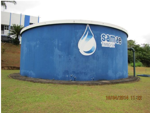
Figura 155 – Reservatório ETA: Vista Geral Detalhe da identificação e pintura em boas condições - conformidade Presença de escada de acesso com gaiola de proteção para os operadores - conformidade
