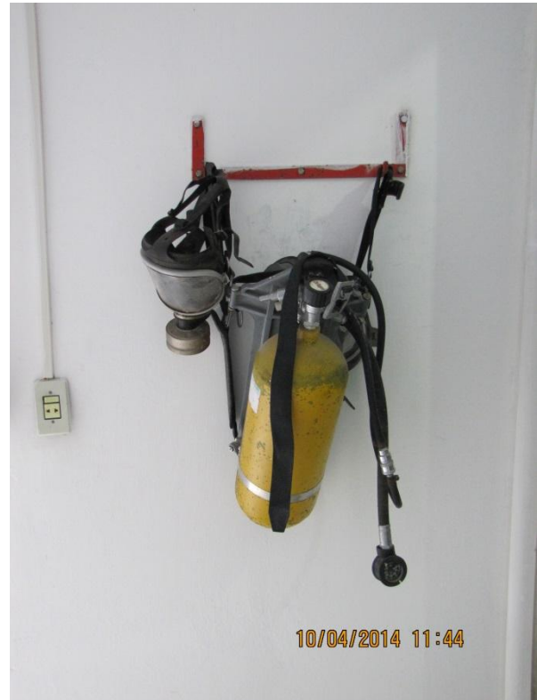
Figura 74 – ETA: Kit de emergência – máscara com aparelho autônomo de respiração a ar comprimido – conformidade
