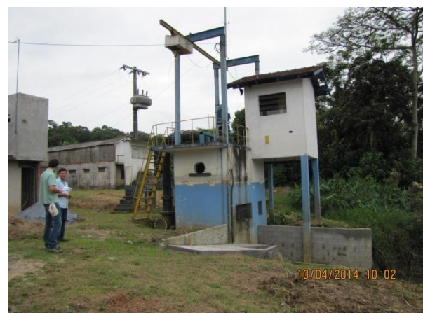
Figura 6 – Captação: Vista geral das instalações
