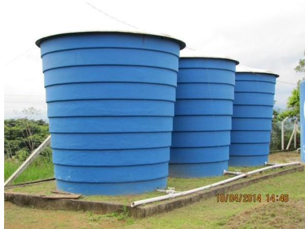
Figura 190 – Reservatório: Vista geral
