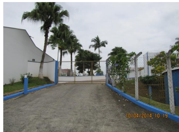
Figura 22 – ETA: Portão de acesso contra a entrada de estranhos - conformidade
