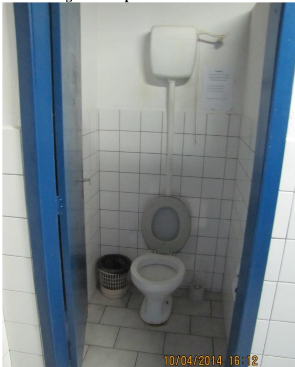
Figura 224 – Escritório Operacional: Detalhe do banheiro dos funcionários em condições satisfatórias de higiene e limpeza - conformidade
