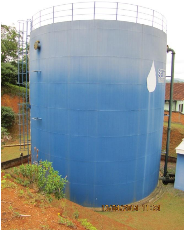
Figura 153 – Reservatório ETA: Vista geral. Presença de pintura de identificação da autarquia – conformidade Escada de acesso com gaiola de proteção e guarda- corpo no topo do reservatório para segurança dos operadores – conformidade
