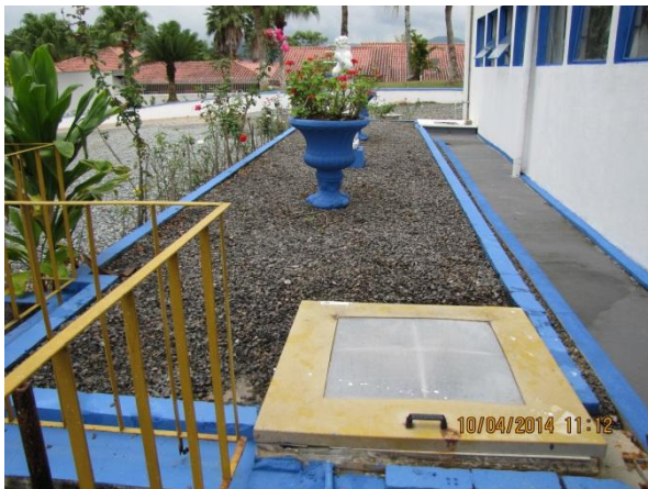
Figura 53 – ETA: Vista geral do tanque de contato - conformidade
