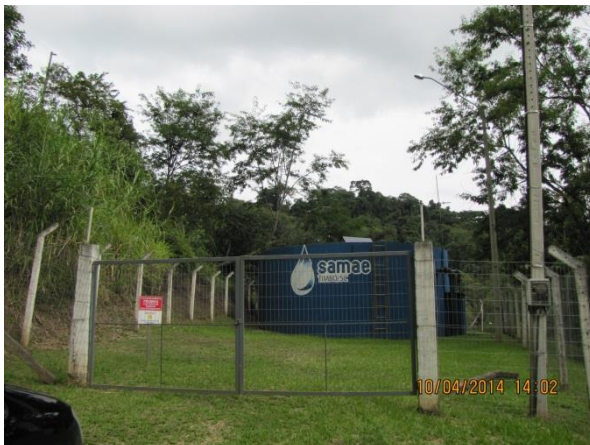
Figura 167 – Reservatório Rua Prof. Alvin Laemmel: Vista geral Presença de cerca de isolamento e portão de acesso com travamento adequado - conformidade
