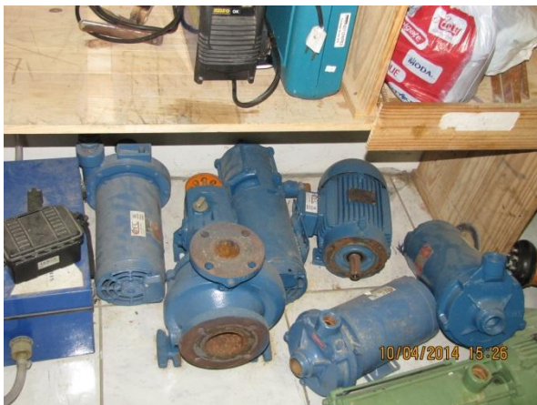
Figura 212 – Almoxarifado: Depósito das bombas em contato direto com o piso podendo ocasionar avarias ao revestimento externo e/ou piso – não conformidade
