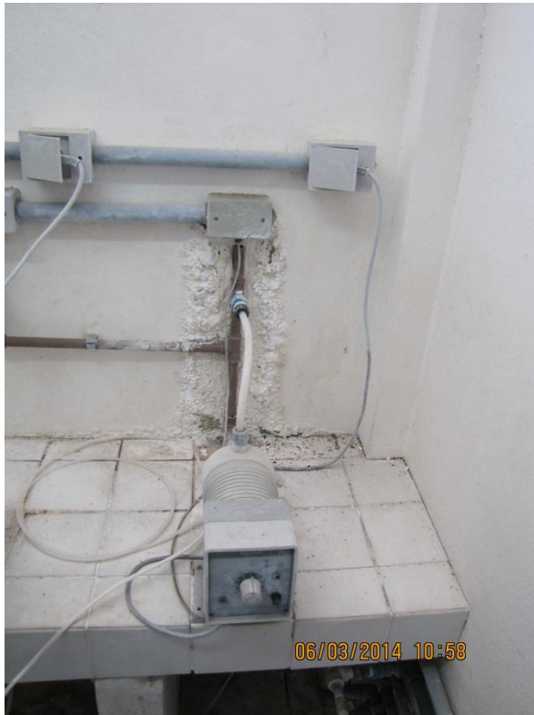
Figura 69 – ETA II: Vazamento danificando pintura e parte elétrica do dosador – não conformidade
