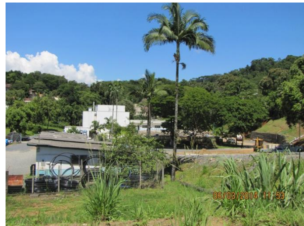
Figura 24 – ETA II: Vista geral dos fundos. Ausência de cercamento adequado, fácil acesso de estranhos aos ambientes da ETA – não conformidade
