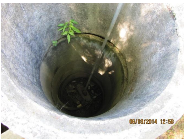
Figura 55 – ETA II: Registro de manobra do descarte
