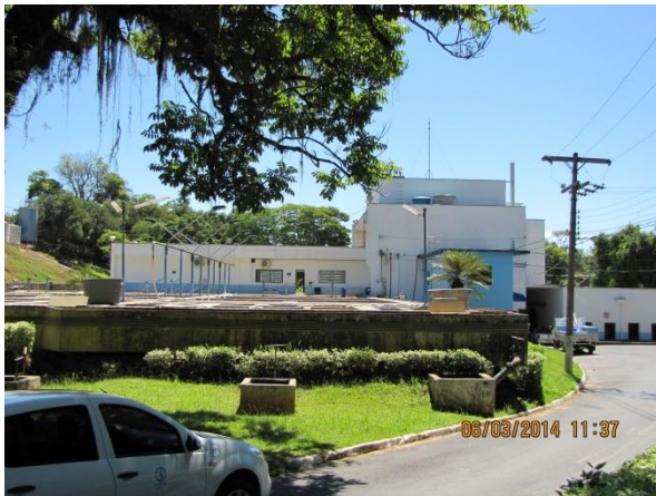
Figura 23 – ETA II: Vista geral
