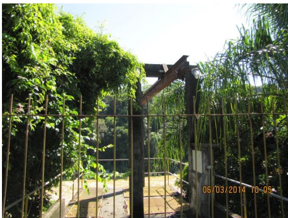
Figura 7 – Captação ETA II: Vista geral das instalações da Estação Elevatória
