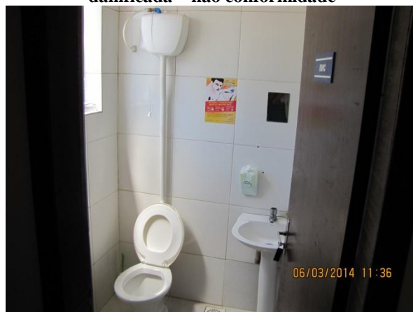
Figura 106 – ETA II: Banheiro em boas condições de higiene e limpeza - conformidade
