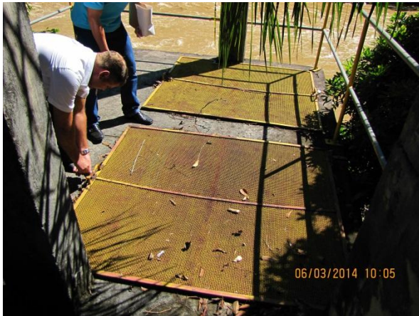
Figura 5 – Captação ETA II: Grade de proteção do poço de bombeamento - conformidade
