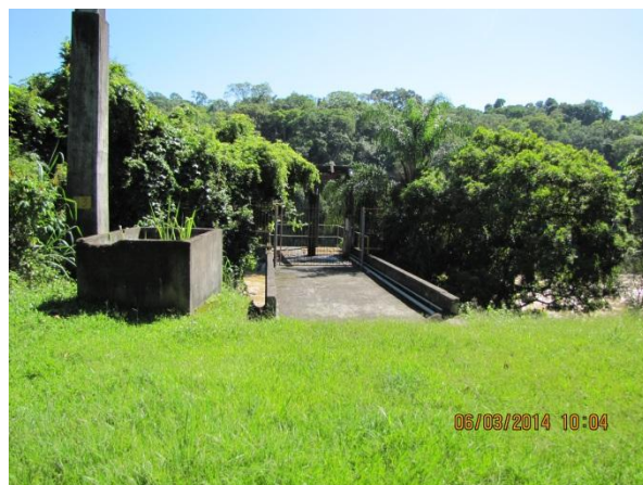
Figura 4 – Captação ETA II: Vista geral do acesso as instalações da Estação Elevatória
