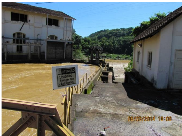
Figura 1 – Captação ETA II: Vista geral do ponto de captação com sinalização contra o acesso de estranhos - conformidade
