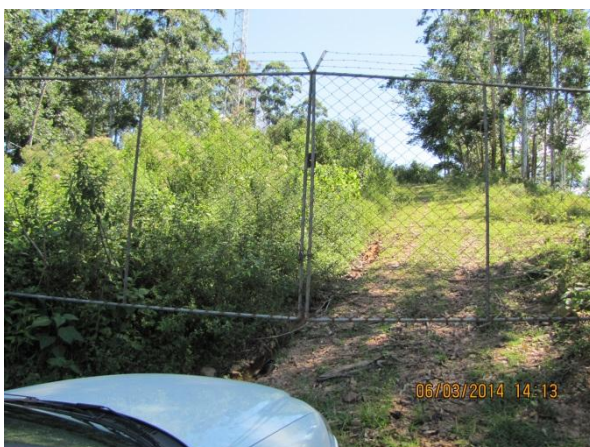
Figura 113 – Reservatório R9: Portão de entrada contra o acesso de estranhos não satisfatório. Ausência de placa de identificação da autarquia – não conformidade
