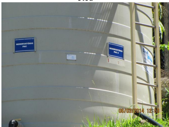
Figura 59 – ETA II: Identificação dos tanques - conformidade
