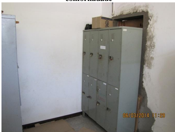
Figura 105 – ETA II: Armário do vestiário em bom estado de conservação - conformidade
