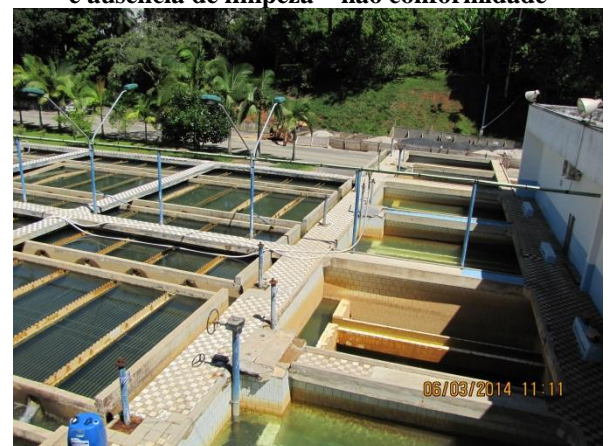
Figura 50 – ETA II: Vista Geral. Sistema iluminação para trabalhos noturnos - conformidade
