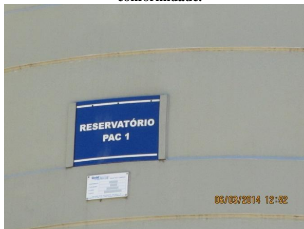
Figura 60 – ETA II: Detalhe da identificação dos tanques - conformidade
