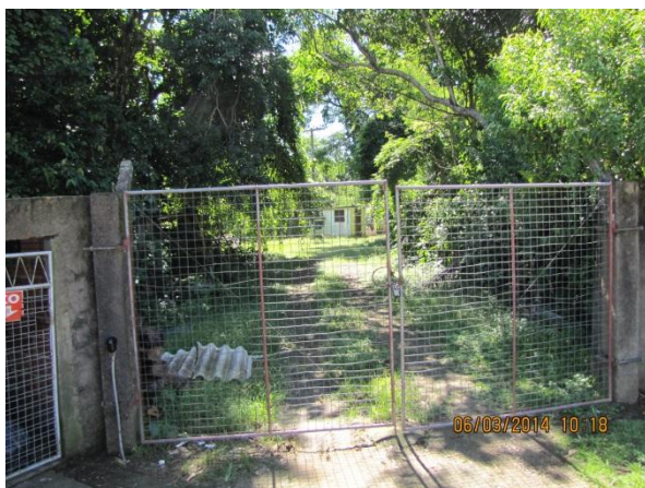
Figura 3 – Captação ETA II: Portão de acesso para a Estação Elevatória sem sinalização identificando ser uma área destinada ao abastecimento público – não conformidade
