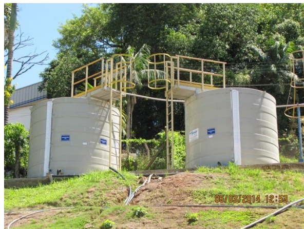
Figura 58 – ETA II: Segurança de acesso aos tanques - conformidade.
