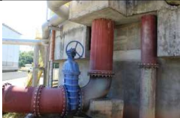
ETE FORTALEZA - MONTAGEM HIDROMECÂNICA NA ENTRADA E SAÍDA
