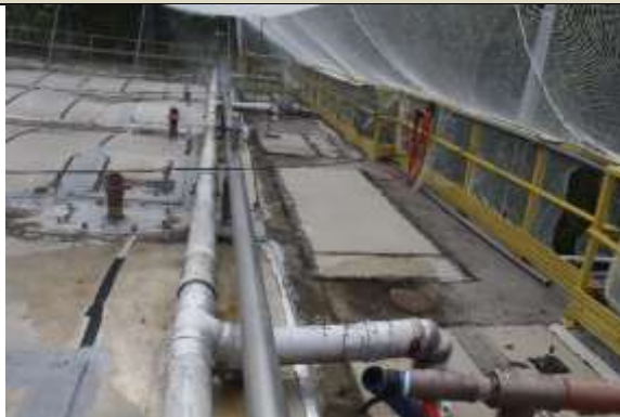
FECHAMENTO DA CALHA DE SAÍDA DE LODO DO REATOR UASB
