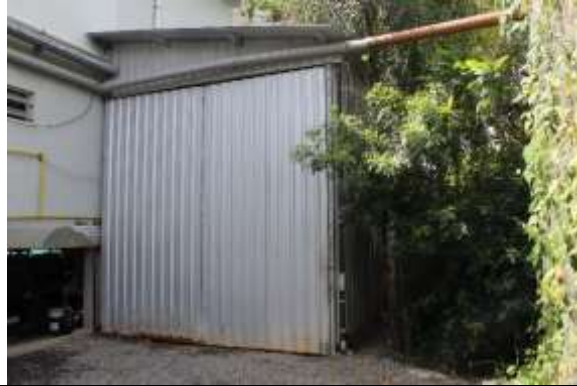
FECHAMENTO METÁLICO PARA COBERTURA DA CAIXA DE LODO
