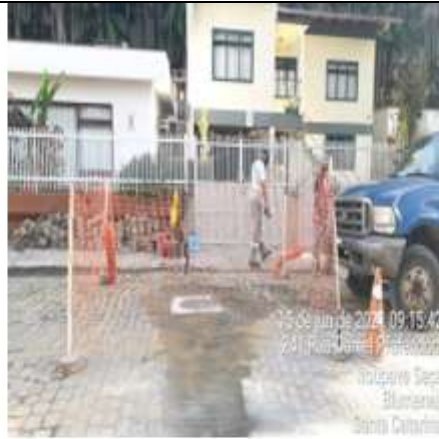
Foto 44 – Execução da Faixa sanitária, entre Rua Daniel Pfaffendorf e Teresópolis – Vinculado a NF 336
