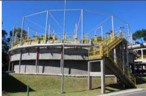
ETE FORTALEZA - INSTALAÇÃO DO GUARDA CORPO DA ESCADA
