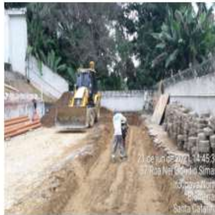
Foto 45 – Execução da Faixa sanitária, entre Rua Santa Quitéria e São Bernardo – Vinculado a NF 336
